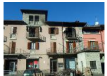
Il palazzo di Marcheno danneggiato
