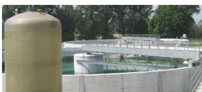
Depurazione del Garda: l'intricata matassa non si sbrogia
