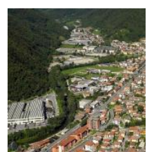
Il raccordo autostradale parte
